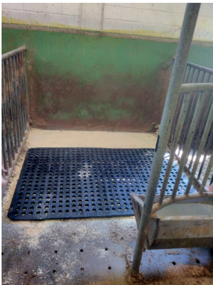
Fig. 43 și fig. 44: Detaliu de boxă pentru animale bolnave: covor fixat, din cauciuc perforat, așternut din rumeguș. În fața covorului fixat, sub perforațiile din podea, este un canal pentru evacuarea lichidelor. Gradul de înclinare a pantei spre canalul der evacuare: 2,5 – 3,5 %. (© E. Gerstenkorn)
