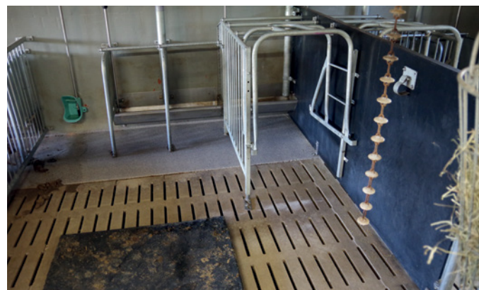
Fig. 46: Boxă pentru animale bolnave cu amenajări pentru imobilizare de scurtă durată în vederea efectuării de tratamente și prelevării de probe. (© LLH)
